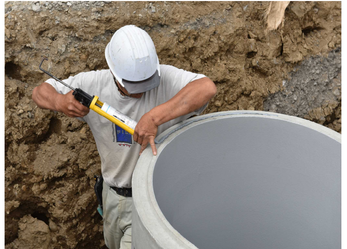
② 接合部に専用シーリング材を塗布
