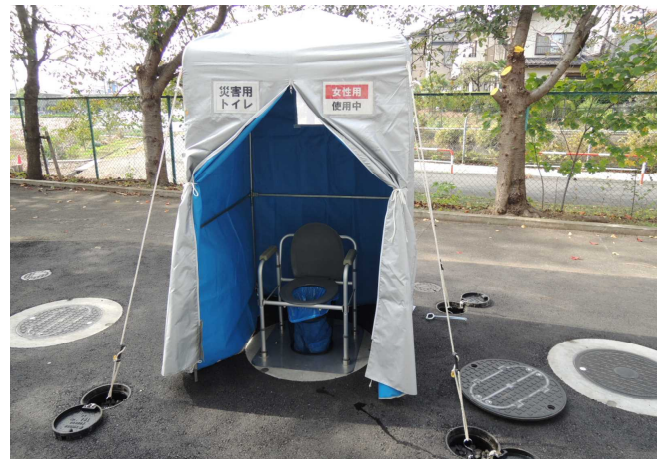
⑪ トイレテントを設置 (専用テント支持金物にロープで固定)
