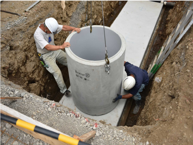
① 所定の位置に本体（便槽）を設置
