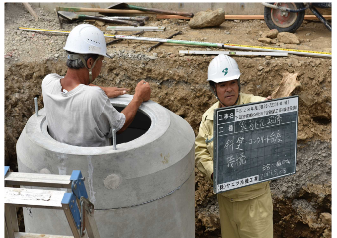
④ 天端に調整リング固定ボルトを設置
