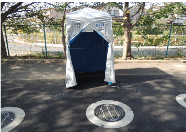
⑩ トイレのテント組立状況
